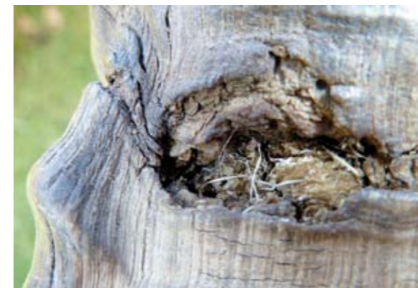
Horndefekt im Bereich eines Jahresringes
